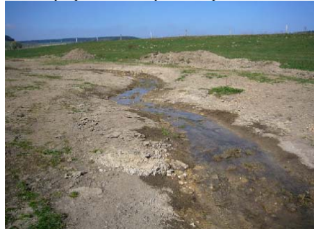
Nově vytvářená meandrující trasa toku při revitalizaci
