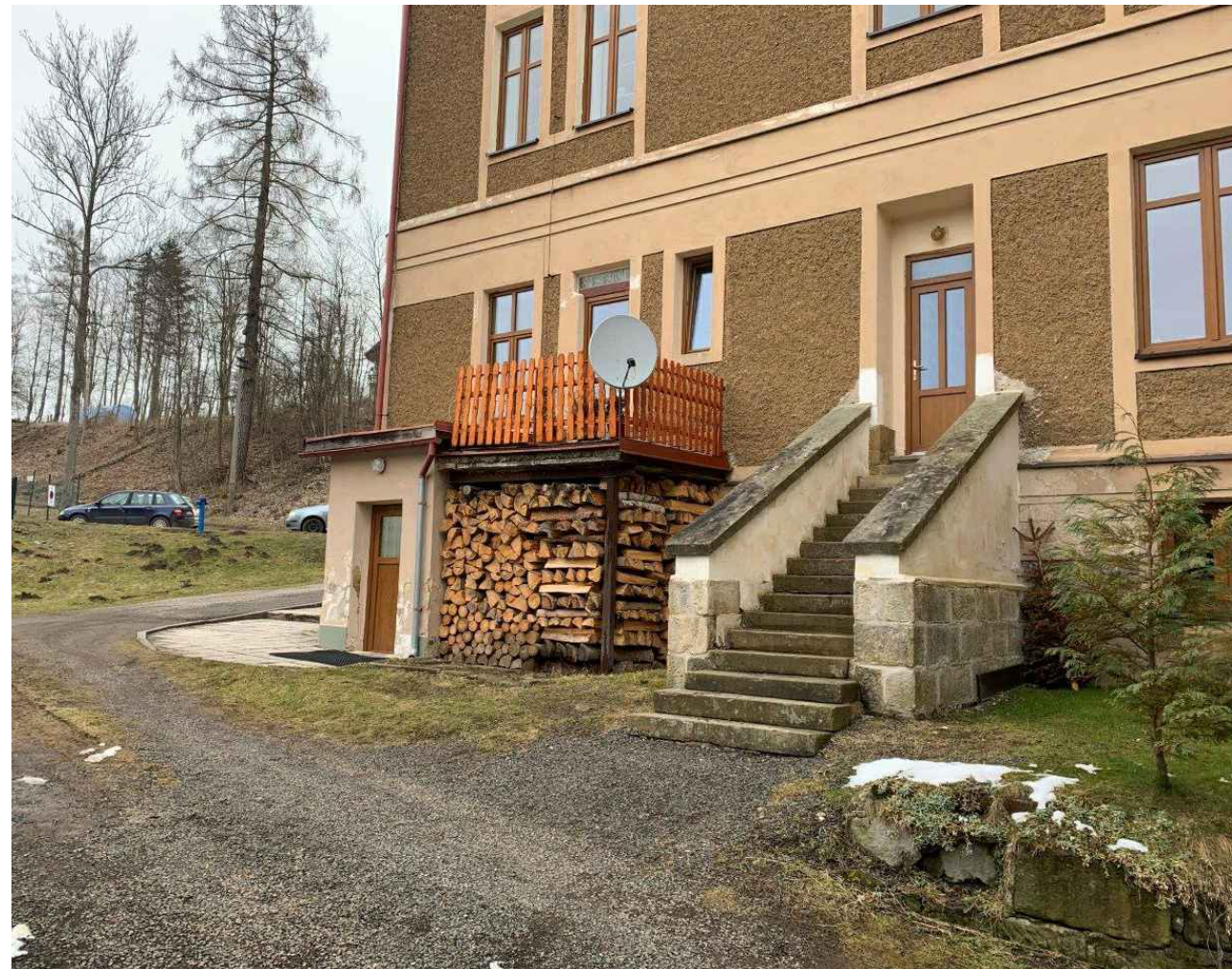
FOTO - STÁVAJÍCÍ STAV
