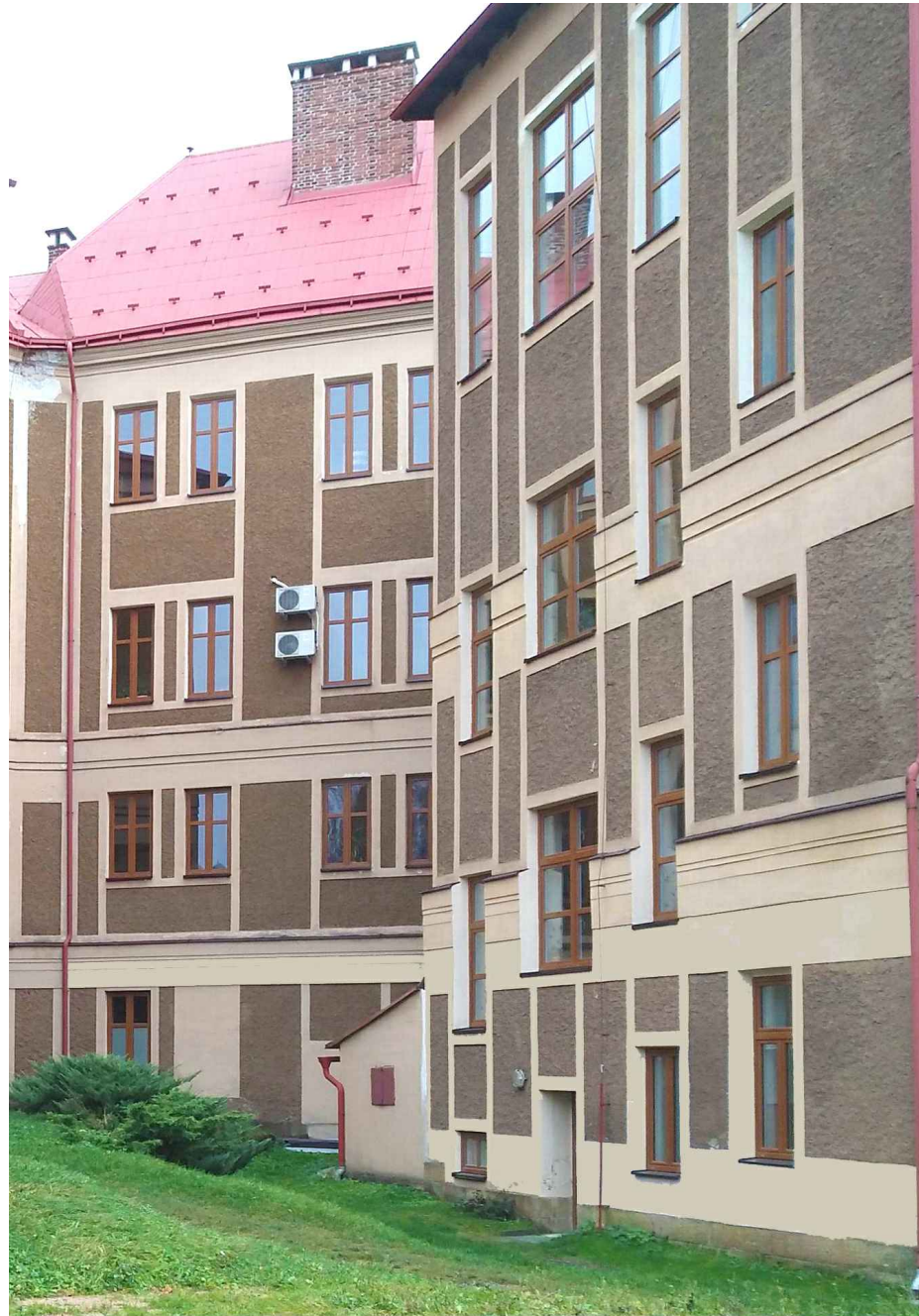
FOTO - STÁVAJÍCÍ STAV
