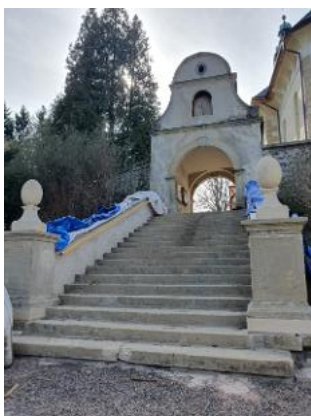
Opravené schodiště zdoňovského farního kostela
